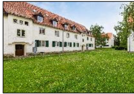
Dresden, Dobritzer Straße
